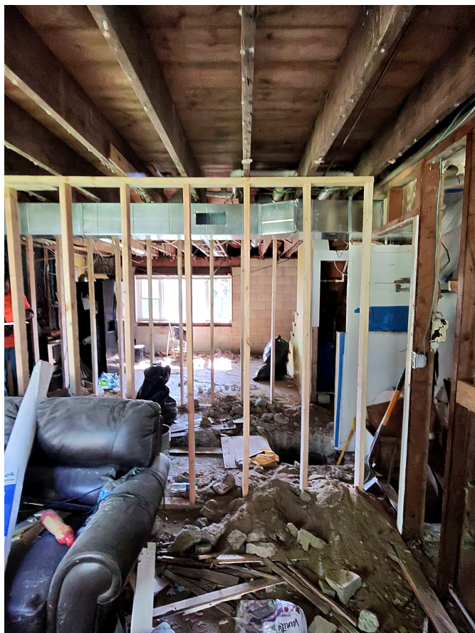
Renovación total — trabajo de estructura.
